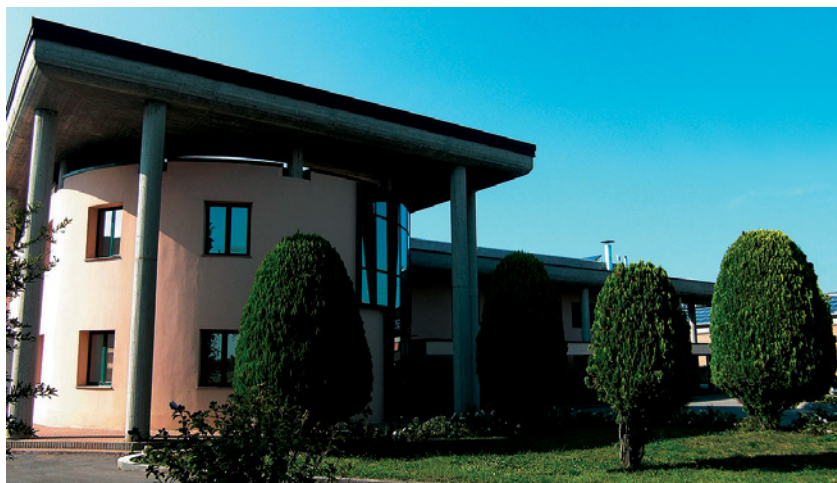
Uno scorcio dell'edificio di ISI Plast a Correggio (Reggio Emilia).
